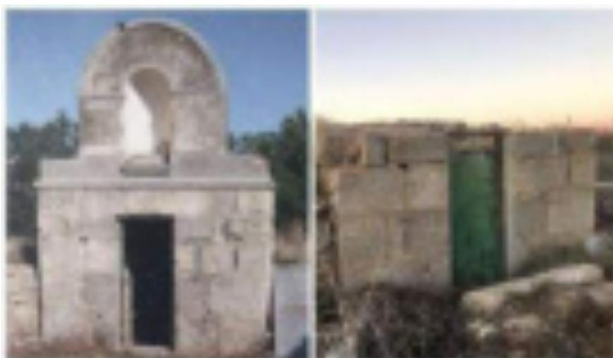
Figura 80. Imagen antigua del arca nº2 (izquierda); estado actual (año 2021) de destrucción del arca en la que falta toda la parte superior de piedra (derecha).
