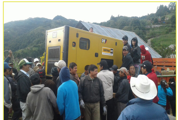
En la imagen, puesta en marcha del generador eléctrico para autoconsumo energético en el Departamento de San Marcos (Guatemala), con la aportación de Cooperativa L'Olivera, COCEDER Cataluña
